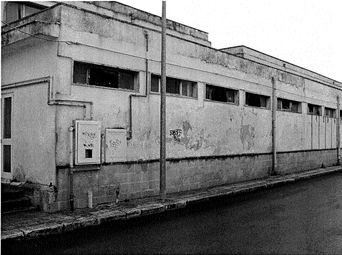
Prospetto su via Machiavelli
