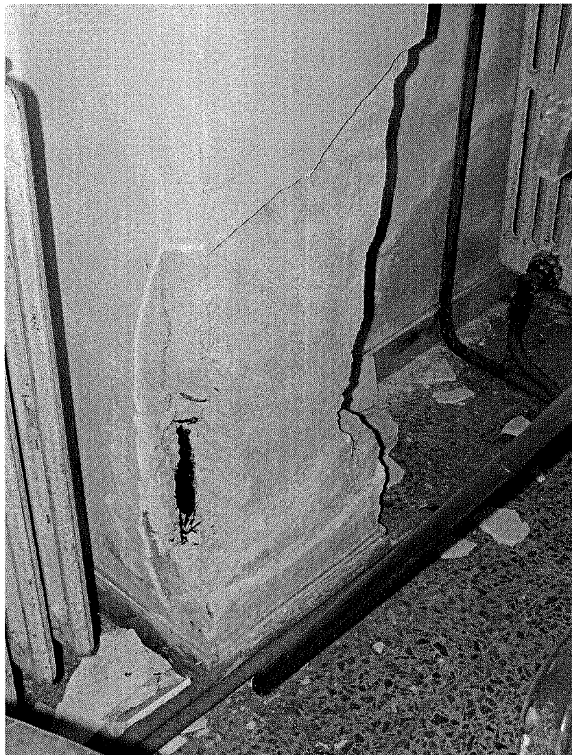
Sala Multiuso – Particolare pilastro al piede
