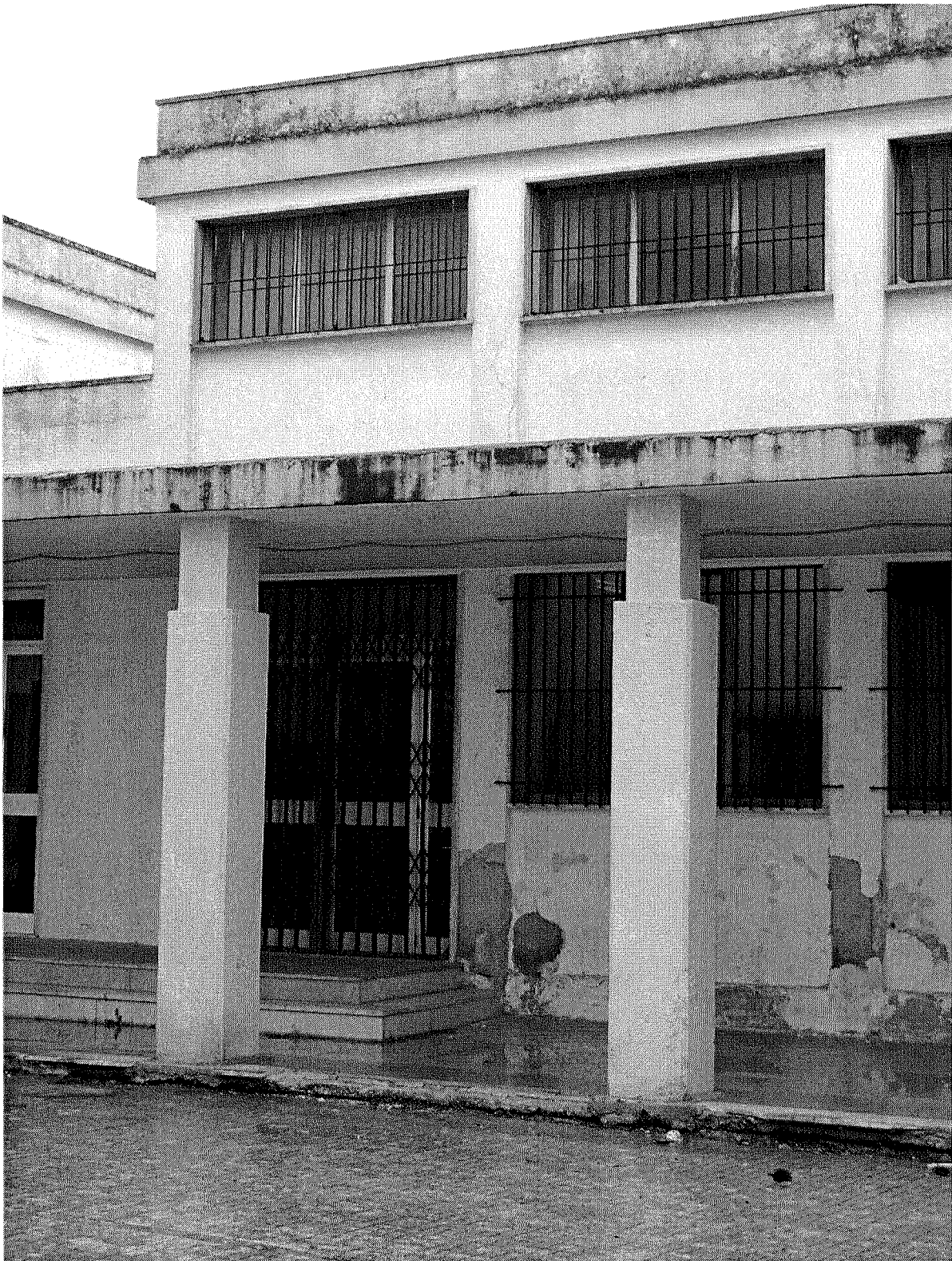
Sala Multiuso – Particolare sull'ingresso dal cortile interno
